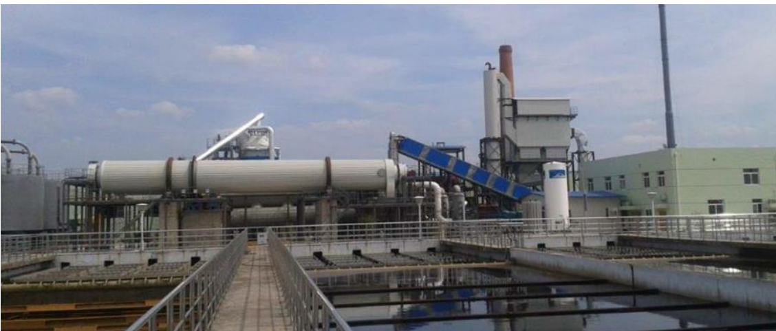
Kuva 3.14. Zheijangin provinssissa, Kiinassa sijaitseva jätevesilietteen pyrolyysilaitos. Etualalla rumpukuivain. (Lähde: Splainex Ecosystems Ltd.)
