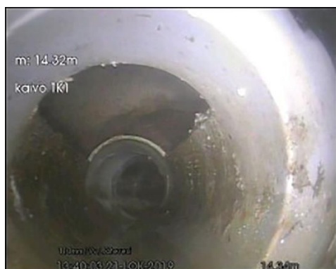
110 mm muovi, tarkastuskaivo
