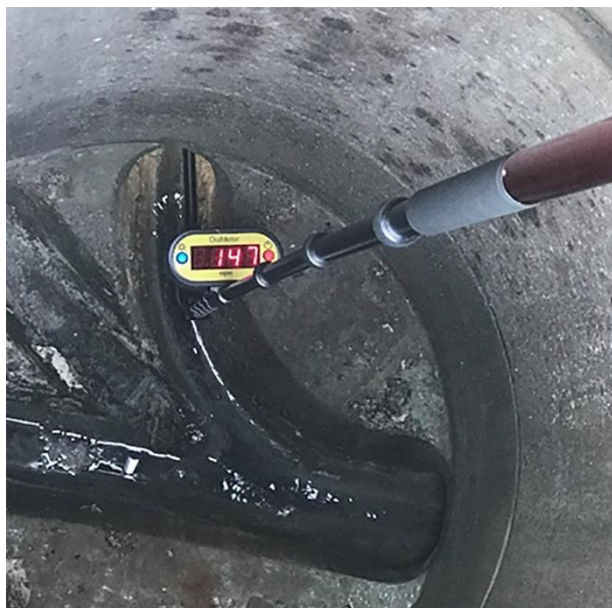
Kuva: SewCon Kuikka Oy
