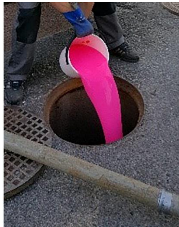
Kuva 26. Esimerkkejä väriainekokeen tekemisestä.
