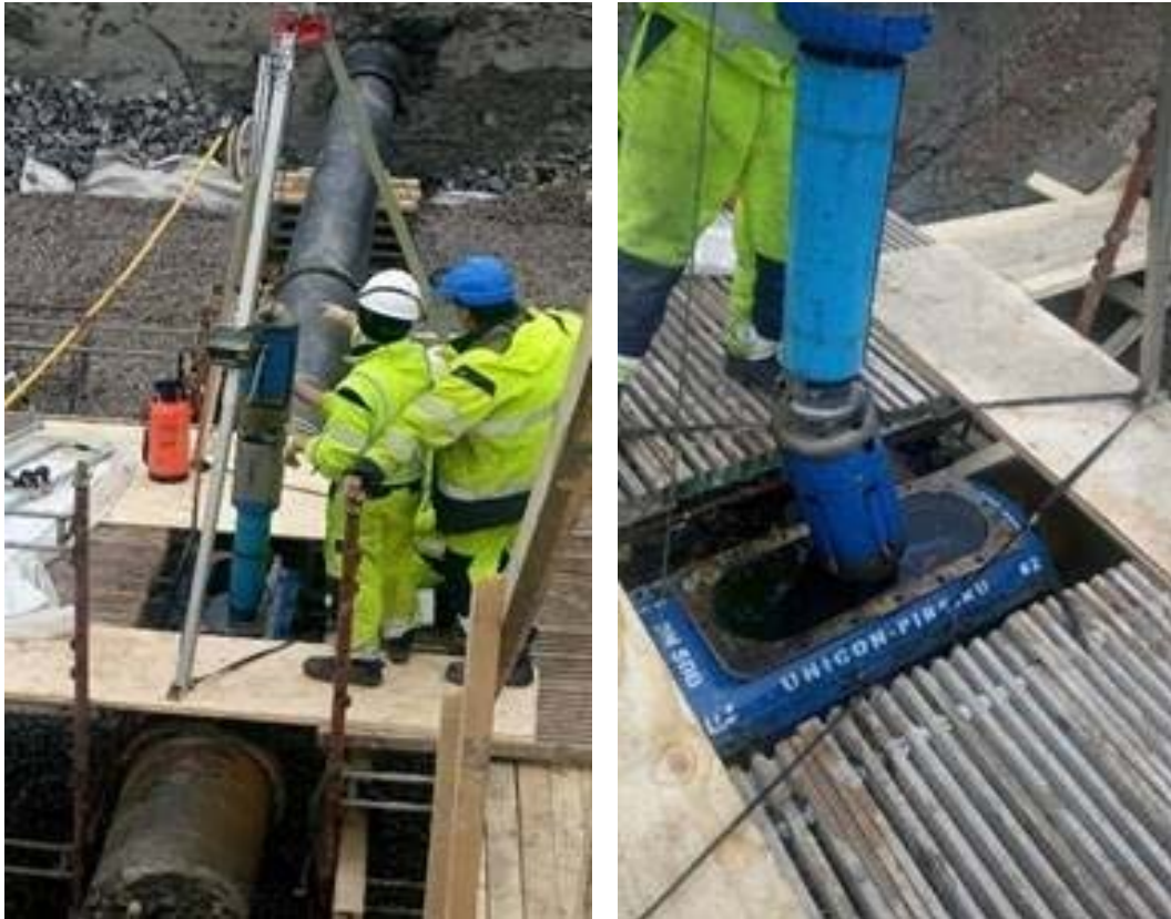
Kuva 26. Putken skannaustyökalun syöttäminen tutkittavaan linjaan. (Kuvat: Lahti Aqua)
