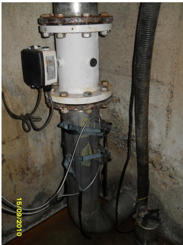
Kuva 8. Limingasta johdettavien jätevesien mittauspiste Lakeuden keskuspuhdistamolla.
